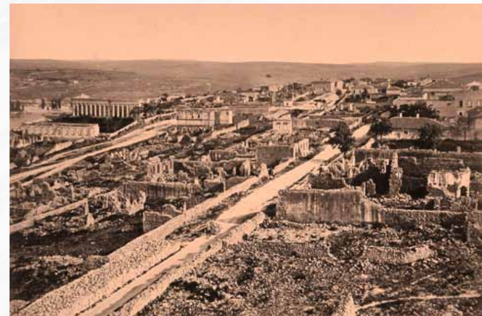
Вид кварталов Центрального городского холма, разрушенных во время Крымской войны. Слева на втором плане – Петропавловская церковь. Фотография 1875 года
