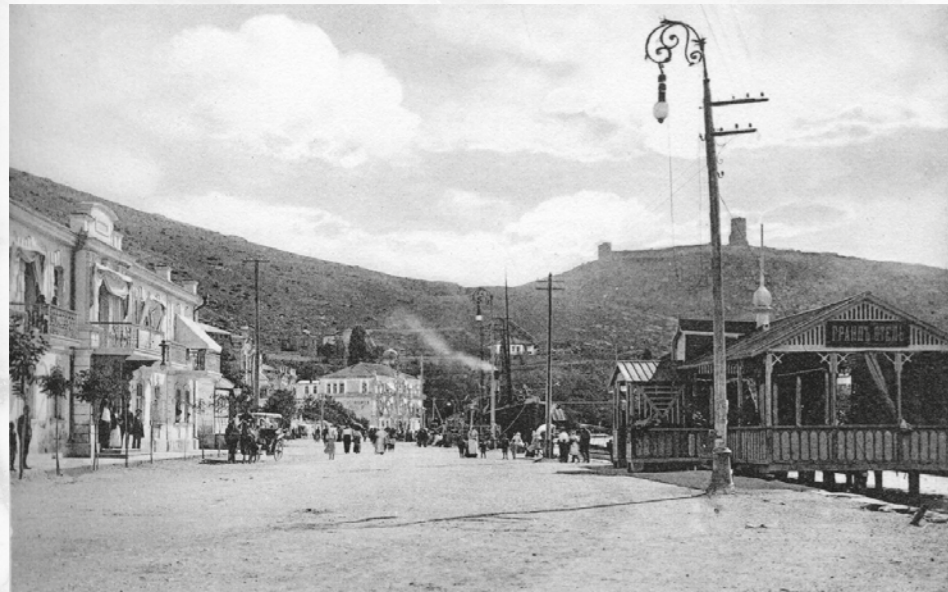
Набережная Балаклавы. 1892 год. Слева – гостиница «Гранд-отель», перед которой – одноимённый ресторан-поплавок; трёхэтажное здание на дальнем плане – гостиница «Россия»
