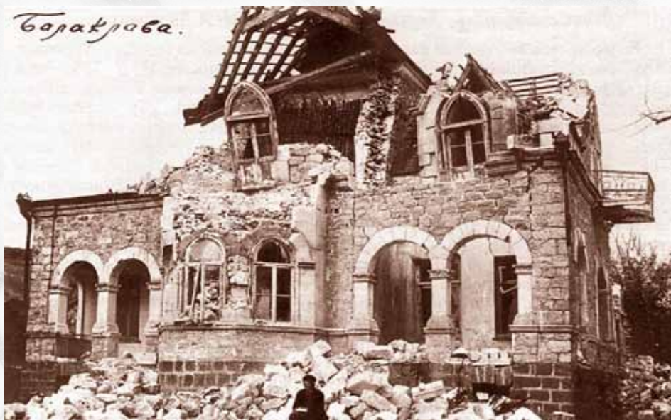
Балаклава. Здание бывшей усадьбы Ревелиоти, пострадавшее во время землетрясения 11 сентября 1927 года
