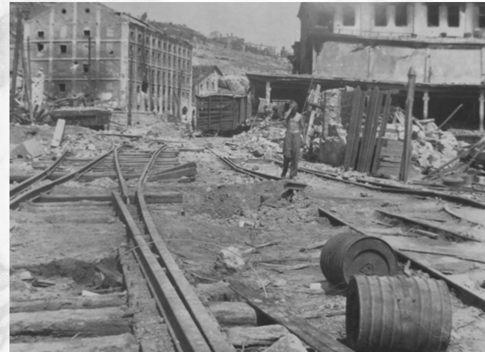
Ремонт разрушенных железнодорожных путей в оккупированном Севастополе. 1943 год
